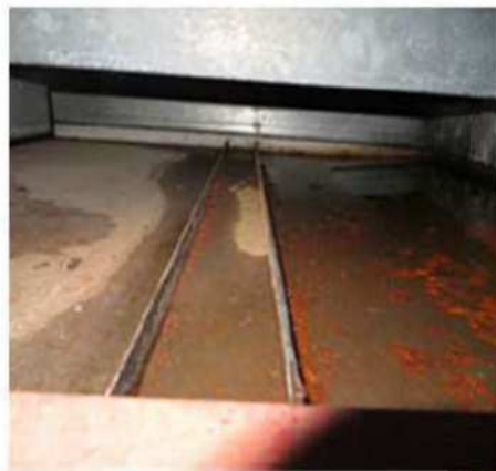
南口駅前センターデッキCDブロック 漏水・滞水・腐食
