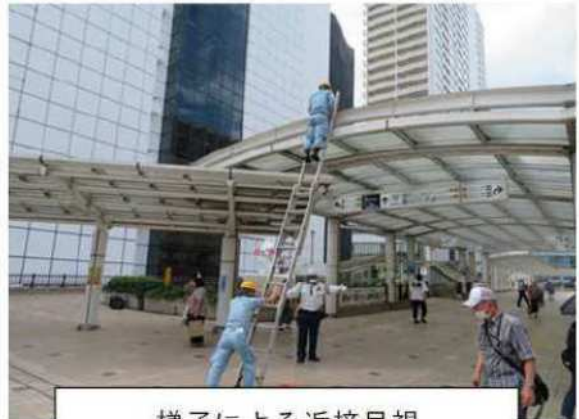
梯子による近接目視
