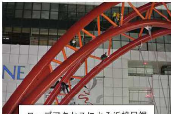
ロープアクセスによる近接目視
