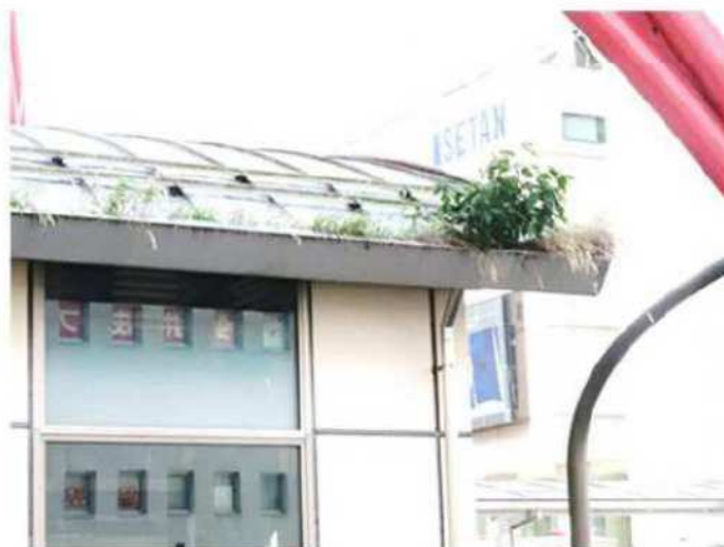
写真 北口駅広場CブロックEVの上
