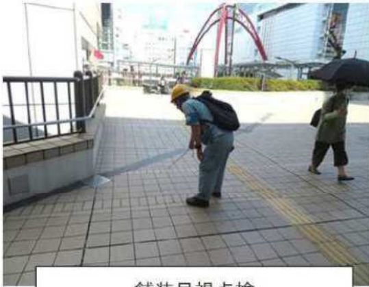
舗装目視点検
