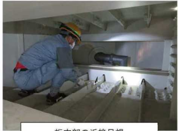
桁内部の近接目視
