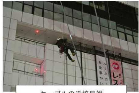
ケーブルの近接目視
