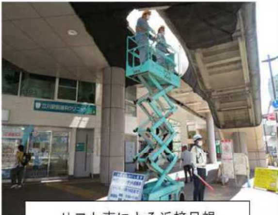
リフト車による近接目視
