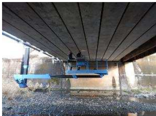
写真 3-3 橋りょう点検車による近接
