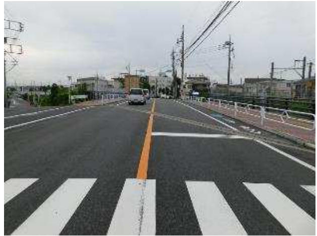
写真 1-2 中央橋補修工事後（橋面補修）
