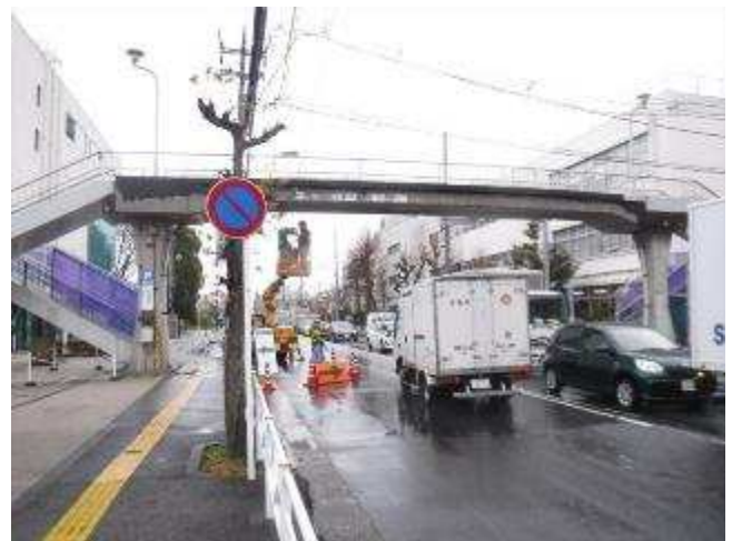
写真 2-6 横断歩道橋：RC 橋（錦歩道橋）
