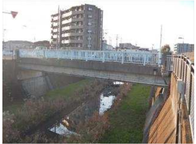
写真 2-2 道路橋：PC 橋（新残堀橋）
