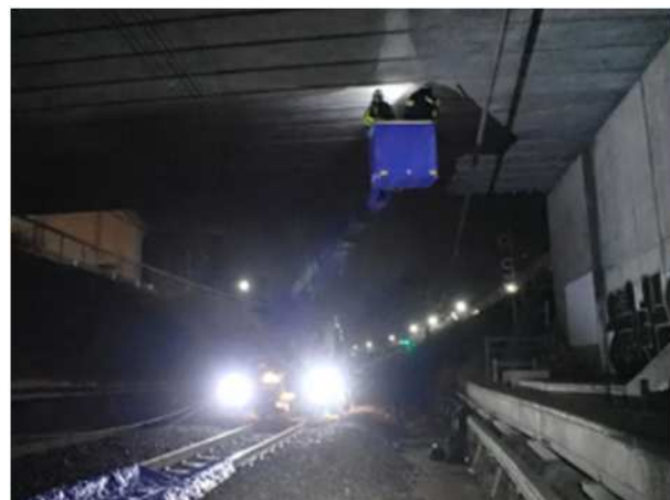
写真 3-4 軌陸車による近接
