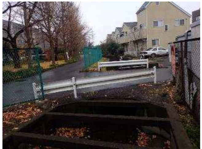
写真 2-4 道路橋：RC 橋 （ボックスカルバート）（7号橋）
