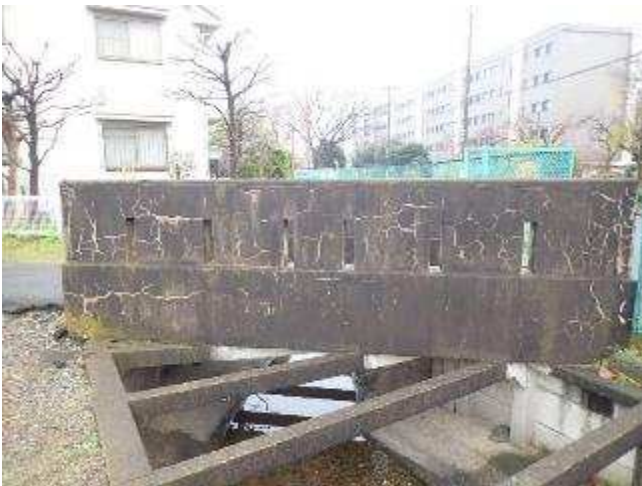
写真 2-3 道路橋：RC 橋（九号橋）
