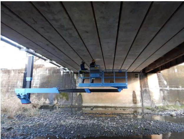
橋梁点検車による近接目視点検
