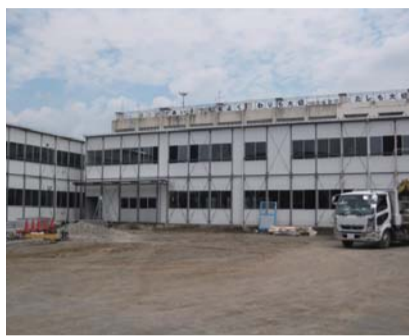
第六小学校の仮設校舎
