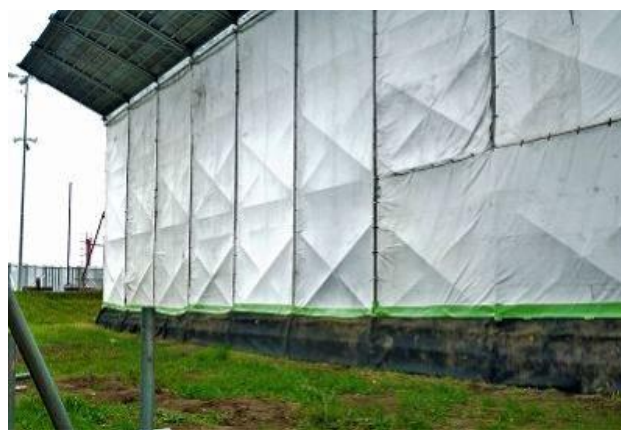
周囲への飛沫飛散防止養生例（外部）
