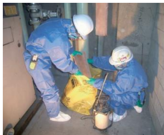
図35 取り外した保温材の梱包 33)
