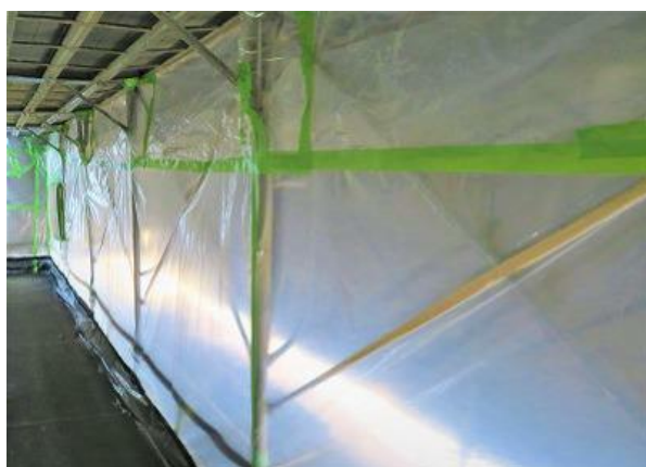
周囲への飛沫飛散防止養生例（内部）
