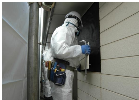
図43 原形のままの手ばらし（外装）
