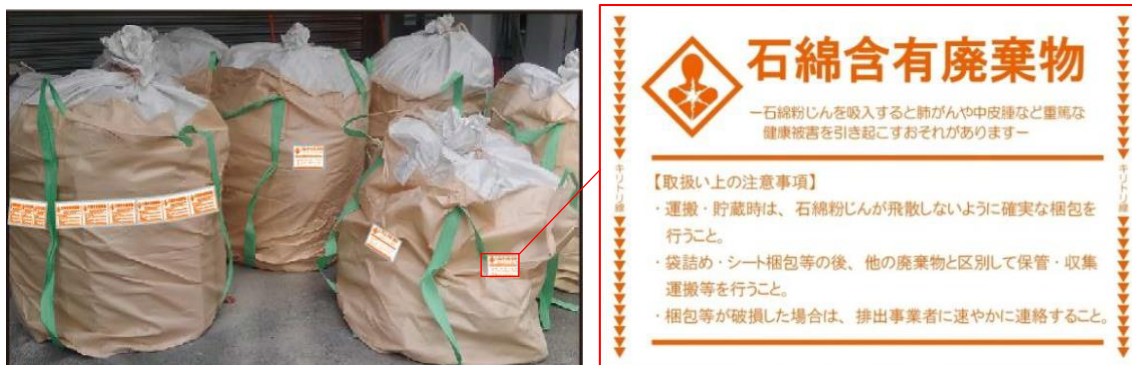
図47 石綿含有産業廃棄物の保管例 石綿含有廃棄物表示テープ 39)
