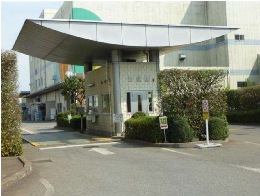
立川市総合リサイクルセンター（西砂町）
