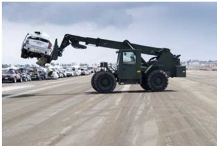
米軍による仙台空港復旧作業 (東日本大震災)
