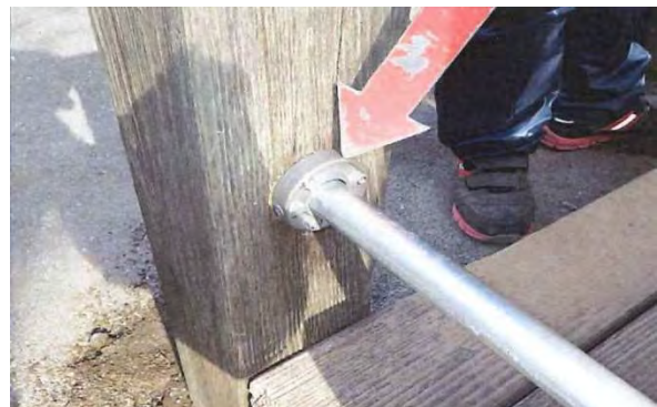
木材や金属の腐食の有無の点検
