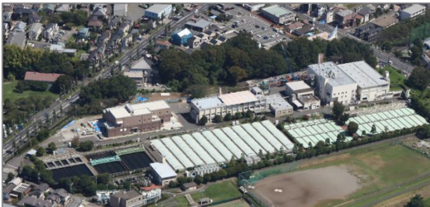
立川市 錦町下水処理場（昭和42年稼働）
