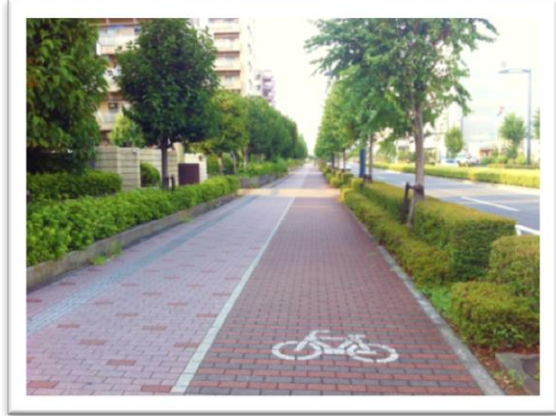
図 2-94 自転車走行空間が 視覚的に分離された歩道 (立川市 市道 1 級 19 号線(西大通り))
