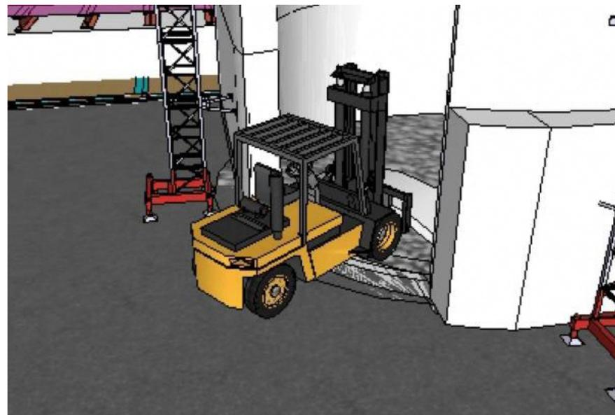
内筒撤去後、外筒はボックストラスを使用して粉塵飛散防止シート養生をし、ウォールソー及びコア、ワイヤーソーにて小さく切断し、タワークレーンにて煙突内部に降ろします。
