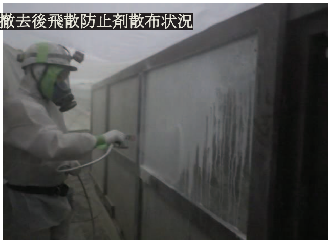
石綿含有仕上塗材撤去状況
