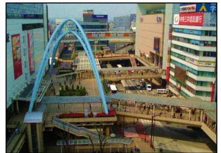
▲ 立川駅北口駅前土地区画整理事業後
