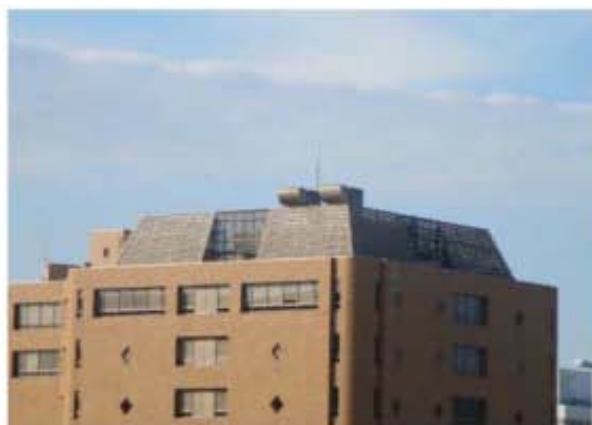
ルーバーによる屋上設備類の遮蔽
