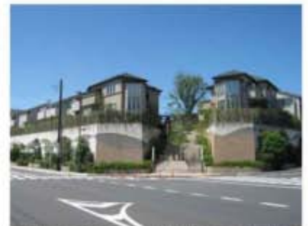
擁壁面の意匠の工夫や緑化による修景
