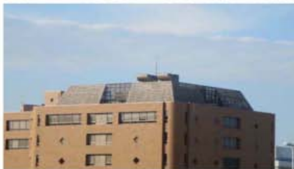
ルーバーによる屋上設備類の遮蔽
