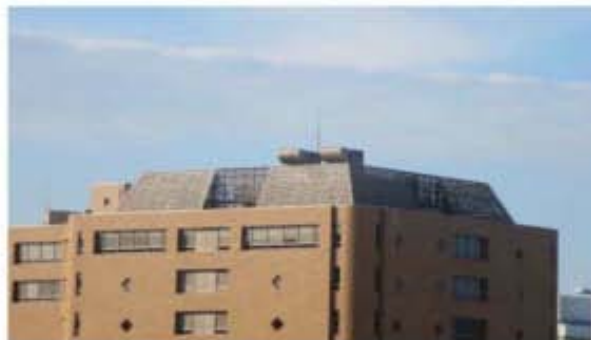
ルーバーによる屋上設備類の遮蔽
