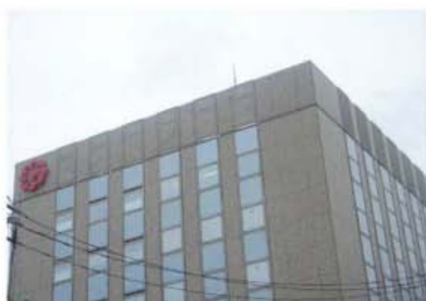
建築物と一体的な計画による屋上設備類の遮蔽
