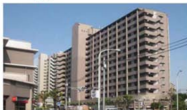
屋外階段と建築物本体との調和
