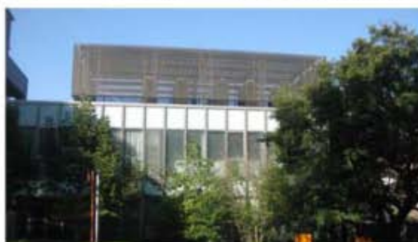
ルーバーによる屋上設備類の遮蔽
