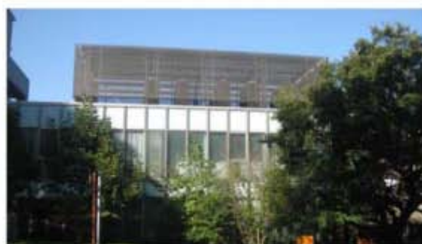
ルーバーによる屋上設備類の遮蔽
