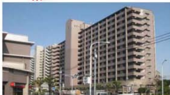
屋外階段と建築物本体との調和
