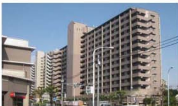
屋外階段と建築物本体との調和
