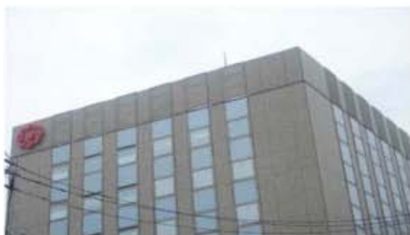
建築物と一体的な計画による屋上設備類の遮蔽
