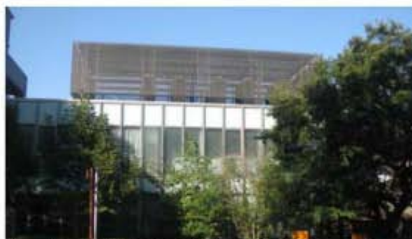
ルーバーによる屋上設備類の遮蔽
