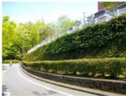
緑化擁壁の活用
