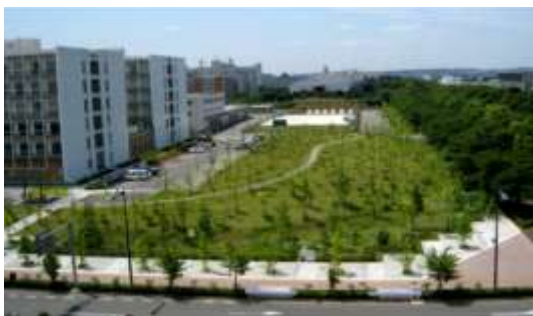
【大規模敷地による広がりある景観】
