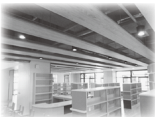
3階図書室の木製ルーバー
