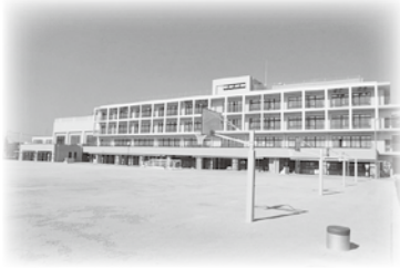
R3.2 工事完了
