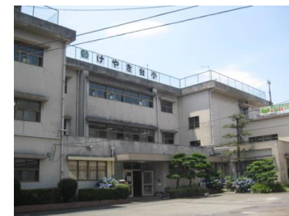
けやき台小学校（昭和41年建築）の校舎を解体し、新校舎を建設します
