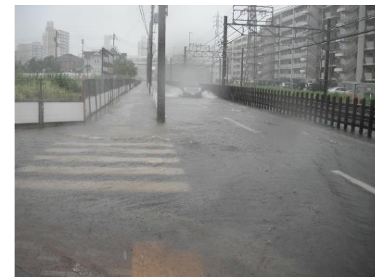
西武線北通り冠水状況
