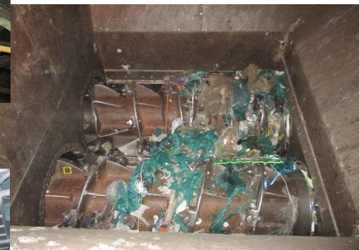
一次破碎設備内部（現在）
