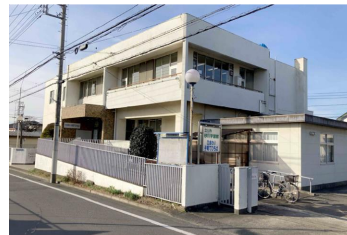
砂川学習館（昭和48年建築）を解体し、複合施設を建設します。
