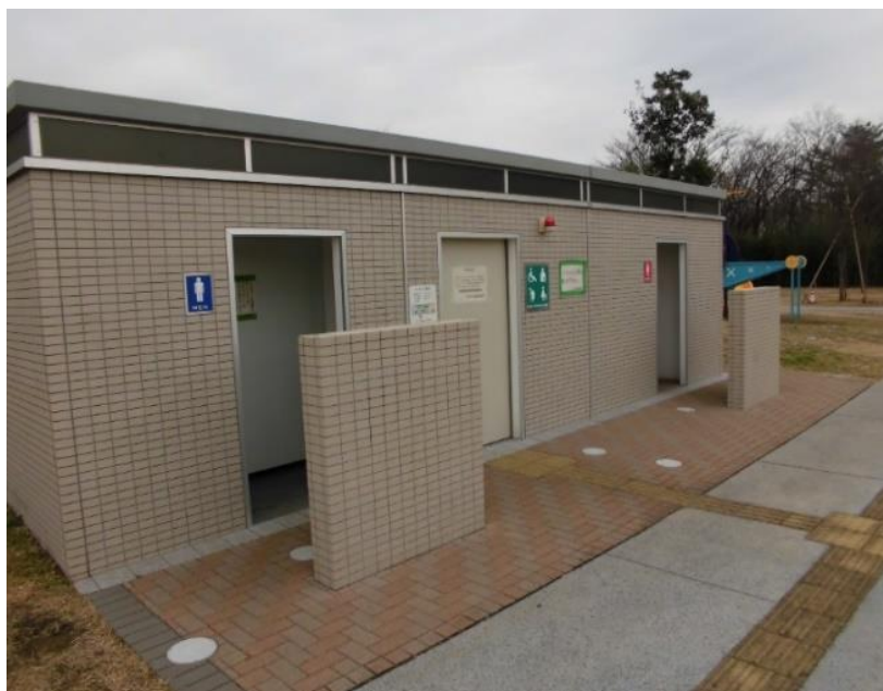
参考：泉町西公園のトイレ (写真はイメージ)
