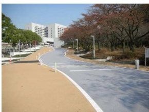
④カーアスファルト舗装
