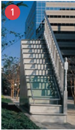
1 □リチャード・ウィルソン イギリス 1953- Richard Wilson UK 1953- 共同溝入口、排気口 entrance to the utility tunnel, vent
