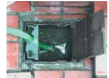
◆水没した埋設型散水栓
