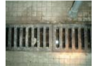
◆受水槽室の排水溝
