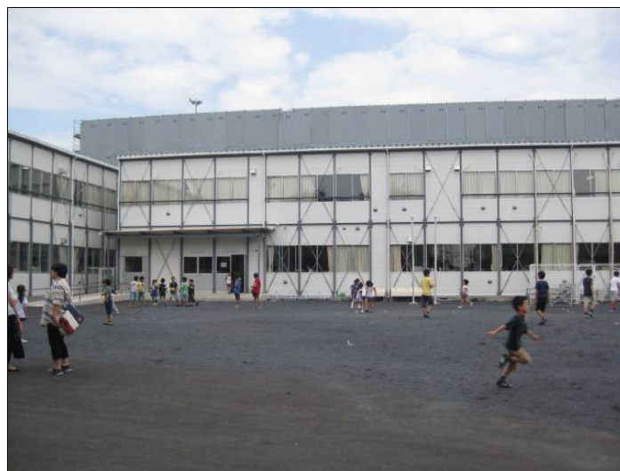
平成 27 年度に大規模改修を実施している第六小学校 の校庭内に建設した仮設校舎
