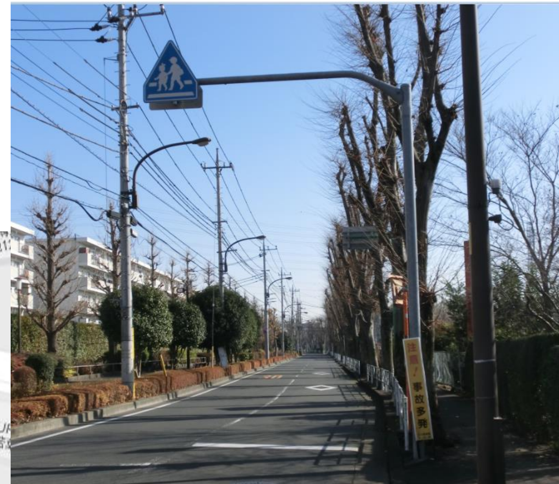
若葉大通り 南側・「横断歩道」標識、「注意！事故多発」看板
