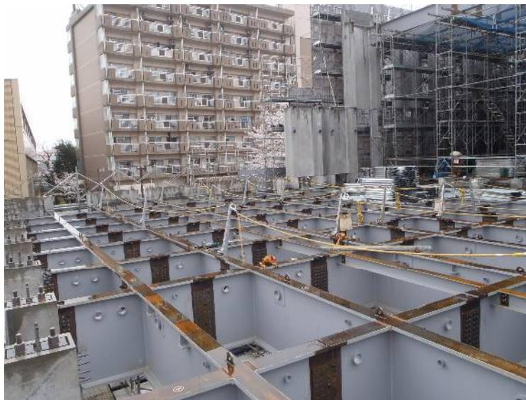
学習館棟の二階床部分です。工場から運び込まれた鉄骨を現場で組み上げ、ボルトや溶接などで固定して行きます。この場所にはこのあと鉄骨の上にスラブと呼ばれる金属製の板を敷き、その上にコンクリートを流し込んで固めたあとに床材などを取り付け、小学校の体育館が作られる予定です。
