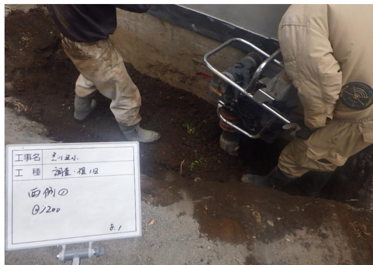
埋め戻し転圧状況(位置図②)
