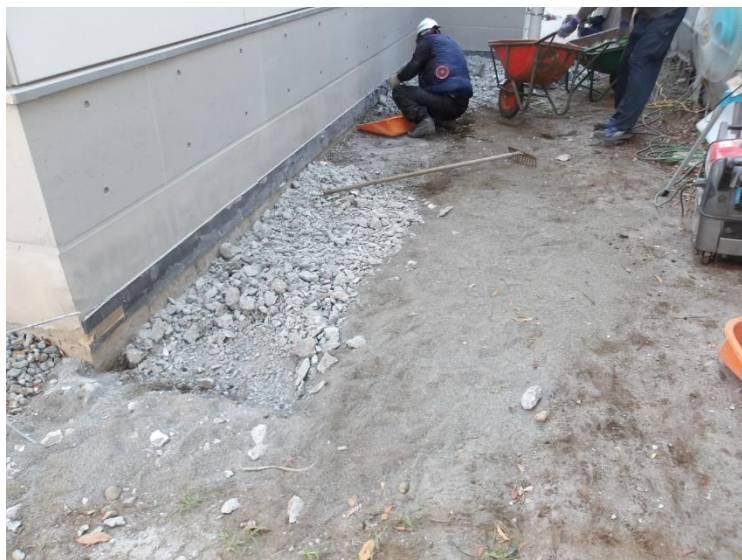
コンリート撤去状況(位置図②)
