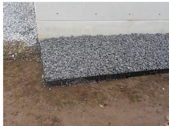
復旧完了状況(位置図②)
