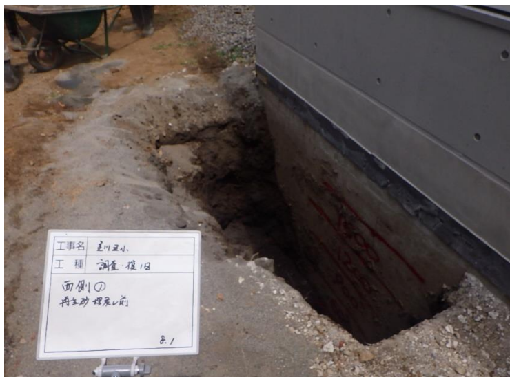
掘削完了状況(位置図②)
