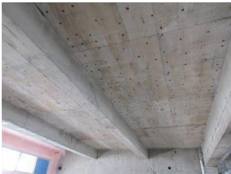
既存スラブ状況
