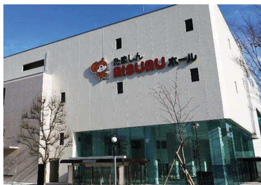
たましん RISURU ホール
