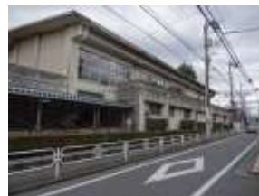
II. 西側道路から体育館を見る
