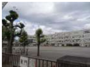
I. 南側道路から校舎を見る
