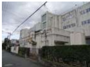
III. 北側道路から校舎を見る
