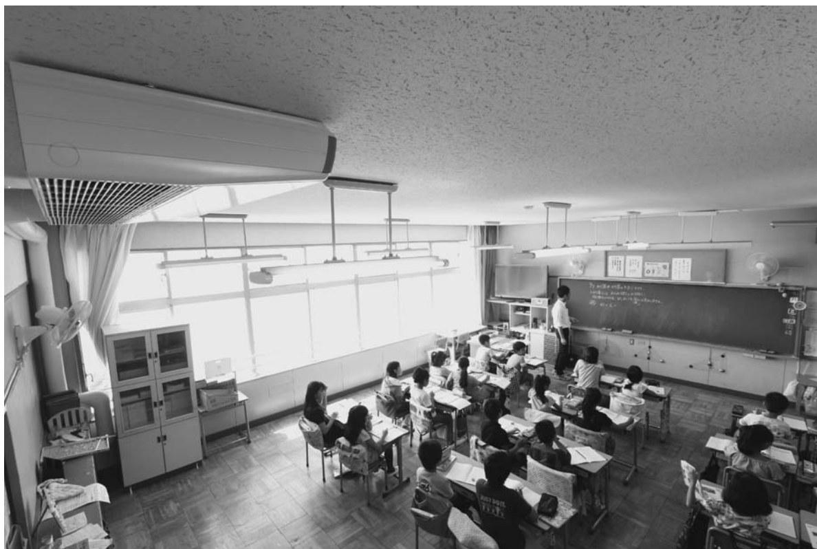
市立小中学校にエアコンを設置（大山小学校）
