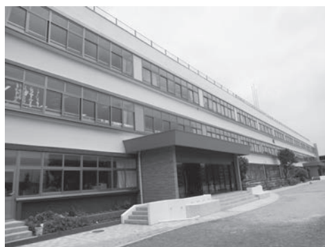
大規模改修後の第八小学校
