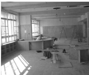
改修中の新生小学校(図書室)
