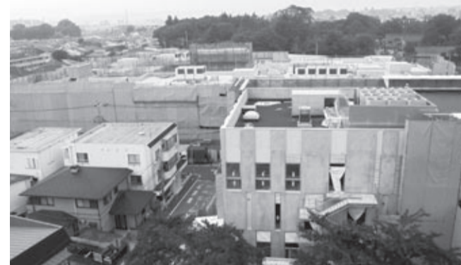
手前が学習館棟、奥側が校舎棟です。
