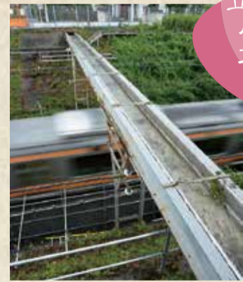
中央線を跨ぐ柴崎分水(改修前)
