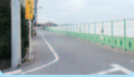
工事をしている通学路
