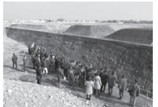
掘削調査の様子
