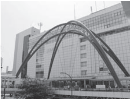
さらなる安全性と回遊性を目指して (JR立川駅北口ペDESTリアンデッキ)
