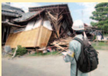
家屋の被害状況を調査する市職員
