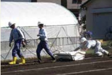
地中レーダー探査の様子
