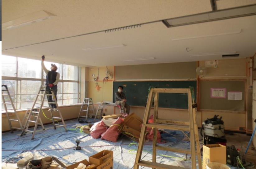
4月の開級に向けて教室改修工事を進めています
