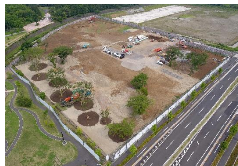
建設地北西から（令和2年6月）
