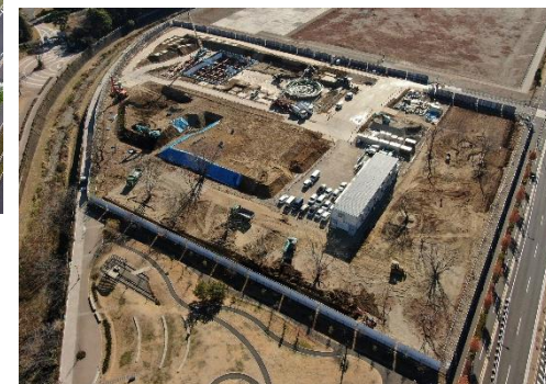
建設地北西から（令和2年12月）
