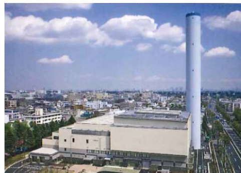
図5 他事例の煙突高さ及び航空障害灯／昼間障害標識の設置状況
