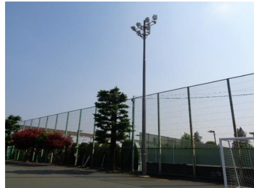
建て替え後の立川第六中学校の夜間照明塔
