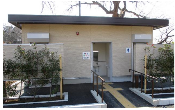
改修後の見影橋公園野球場のトイレ
