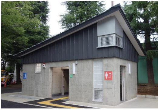
改修後の立川公園野球場のトイレ
