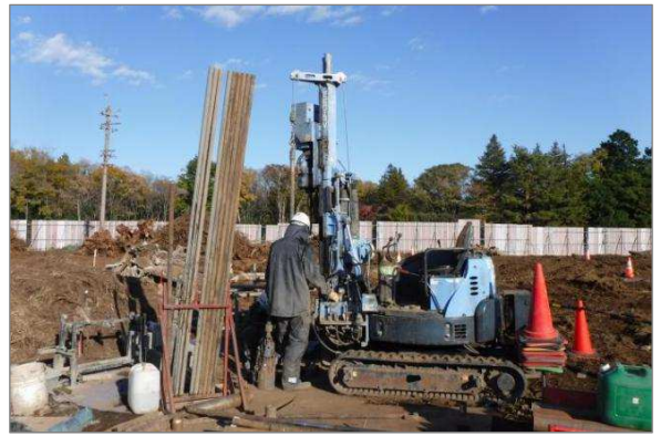
地層・地盤調査
