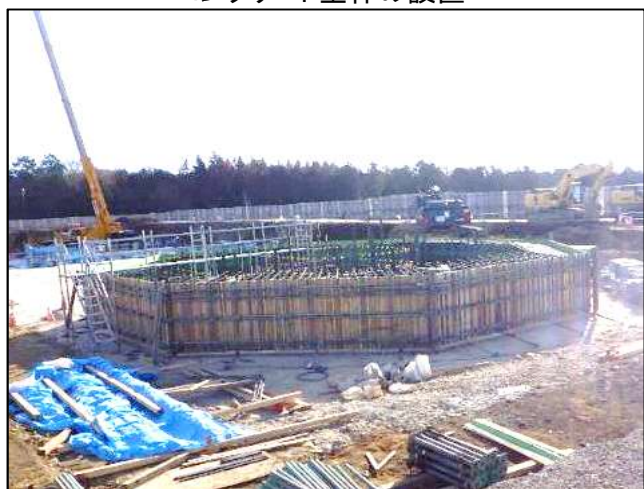
コンクリート型枠の設置
