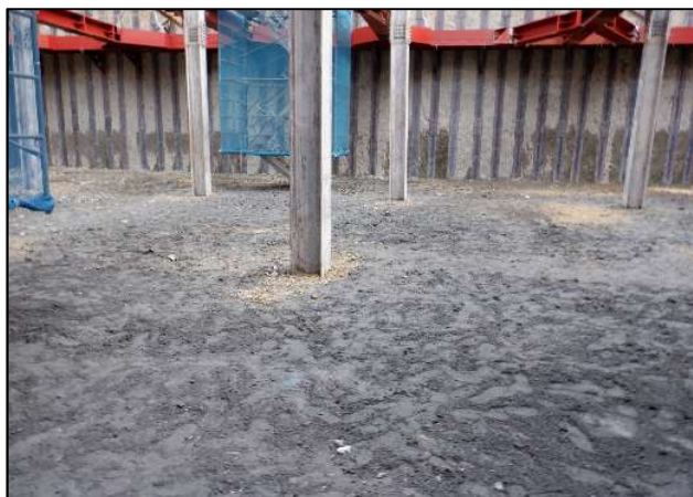
掘削工事完了
