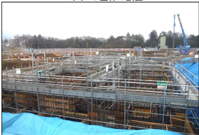
コンクリート型枠の設置
