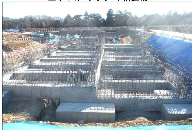
工事中のコンクリート構造物
