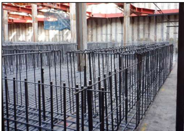
地下の鉄筋配筋
