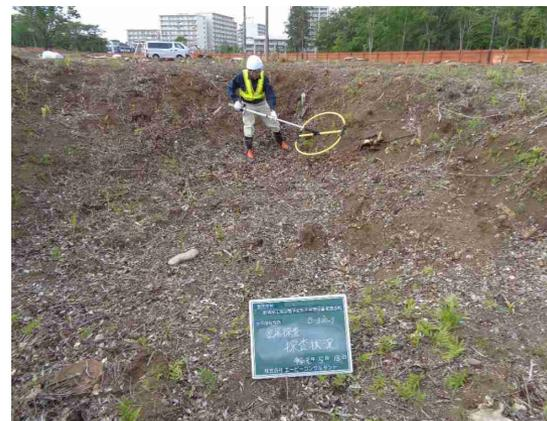
金属探知機による探査
