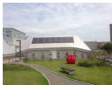
太陽光発電システム (市役所屋上)
