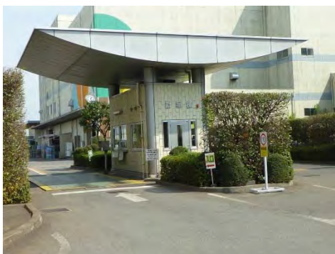
総合リサイクルセンター（計量棟）
