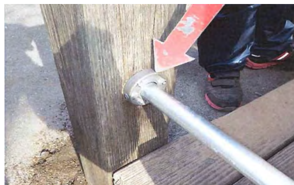
木材や金属の腐食の有無の点検
