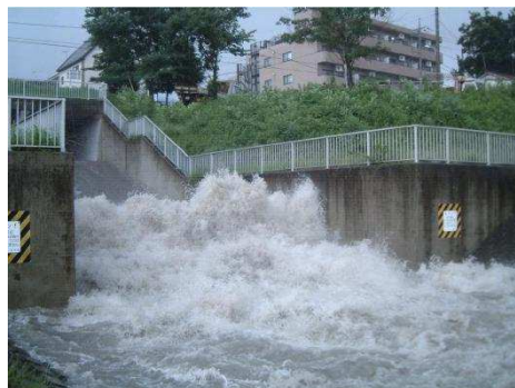
図 4-6 雨天時の緑川幹線吐き口
