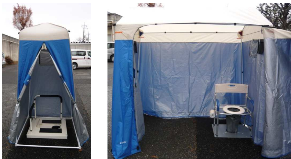
図 4-19 マンホールトイレ
