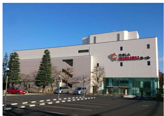
たましん RISURU ホール
